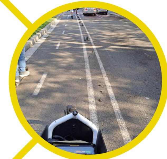
Los tornillos de sujeción permanecen visibles y en mal estado en el asfalto sin los separadores físicos.
