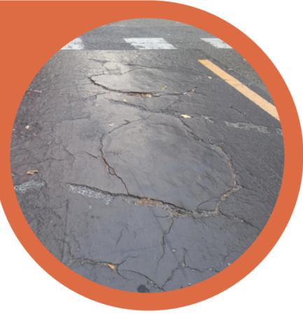
Desgaste en la capa asfáltica de los carriles bici: grietas y agujeros.
