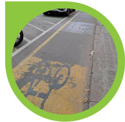
La pintura se encuentra desgastada y deteriorada, perdiendo la señalización dentro del carril bici o en sus demarcaciones.
